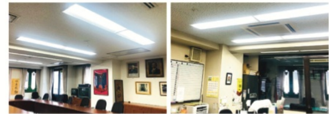
※3階会議室・事務局内のLED化工事後
